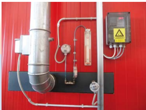
SISTEMA REGOLAZIONE ARIA SECONDARIA СИСТЕМА РЕГУЛИРОВКИ ВТОРИЧНОГО ВОЗДУХА
