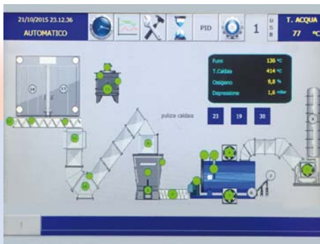
PANNELLO QUADRO ELETTRICO ПАНЕЛЬ ЭЛЕКТРИЧЕСКОГО ЩИТА
