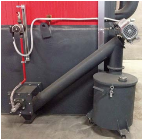
ESTRAZIONE CENERI AUTOMATICO AUTOMATIC ASH REMOVAL SYSTEM
